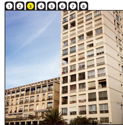
Opération de la Tourette
